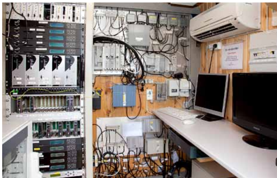
I raket til venstre skal flere enheder fjernes og CMTS'en monteres.
